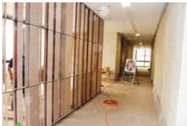
การปรับปรุงพื้นที่อาคารพหลโยธิน ที่ใช้งานมานานกว่า 25 ปี เพื่อลดการใช้พลังงาน
